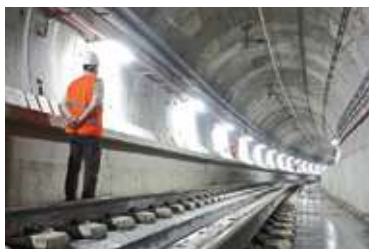
▲ 鉄道トンネル
